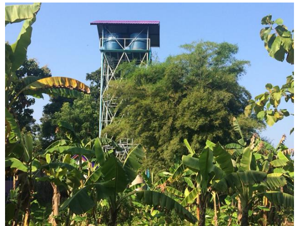
ถังพักน้ำแบบหอสูง เพื่อกระจายไปยังพื้นที่เกษตร
