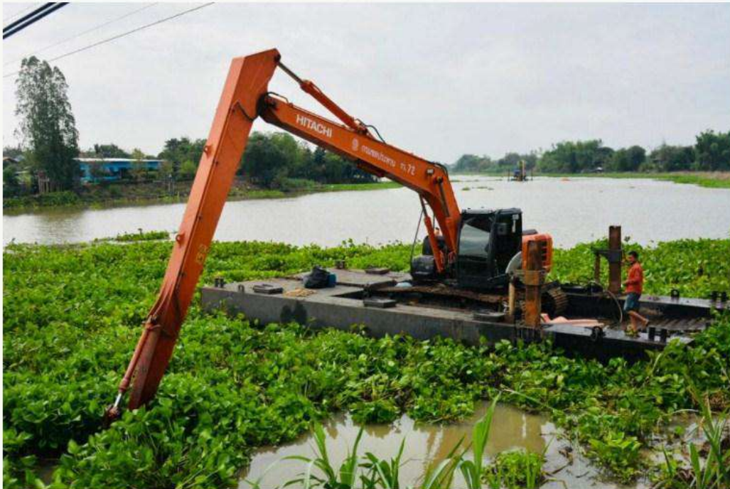
กรมชลประทาน ร่วมกับหน่วยงานที่เกี่ยวข้อง เดินหน้าขุดลอกแม่น้ำบางขาม จังหวัดลพบุรี ทรงแก้ไขปัญหาขาดแคลนน้ำในฤดูแล้งให้ชาวบ้านมีน้ำใช้ตลอดทั้งปี
