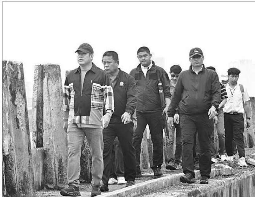
ตรวจพนักงคองกริต - ร.อ.ธรรมนัส พรหมเผ่า รัฐมนตรีว่าการกระทรวงเกษตรและสหกรณ์ ลงพื้นที่ติดตามความก้าวหน้าการซ่อมแซมพนักงคองกริตป้องกันตลิ่งริมแม่น้ำเจ้าพระยาขำรูด บริเวณประตูระบายน้ำและสถานีสูบน้ำบางกรวย ต.บางกรวย อ.บางกรวย จ.นนทบุรี
