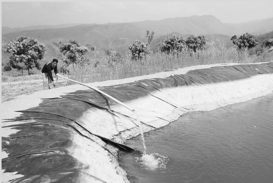
บ่อเก็บน้ำบนดอยที่บ้านแม่วาก
