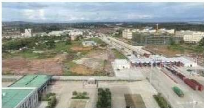
หลังจากรถผ่านการมาเชื้อจะเข้าสู่ด่าน ตรวจการเข้าออก ของคนขับรถและรถยนต์
